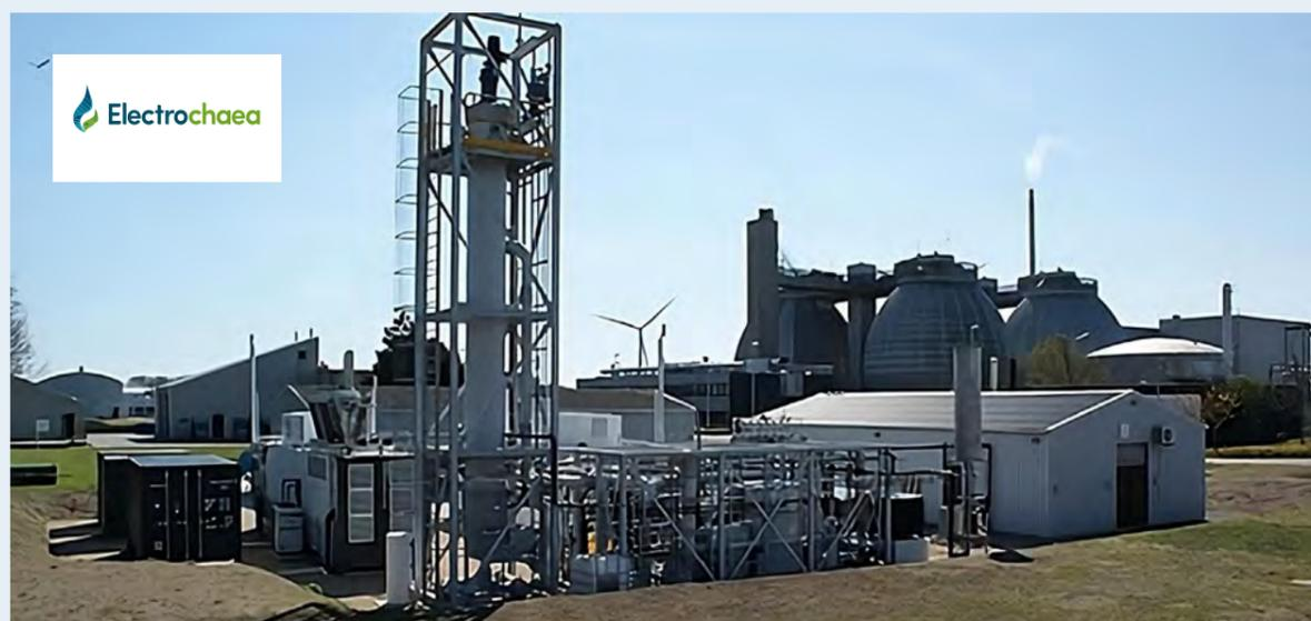
Electrochaea, développeur de technologies Power-to-gas allemand, a développé un micro-organisme archée et un procédé de production de méthane de synthèse pour injection. Le procédé inclut la production d'H<sub>2</sub> par électrolyse (avec de l'électricité renouvelable) et la méthanation biologique de CO<sub>2</sub> à partir du micro-organisme.
